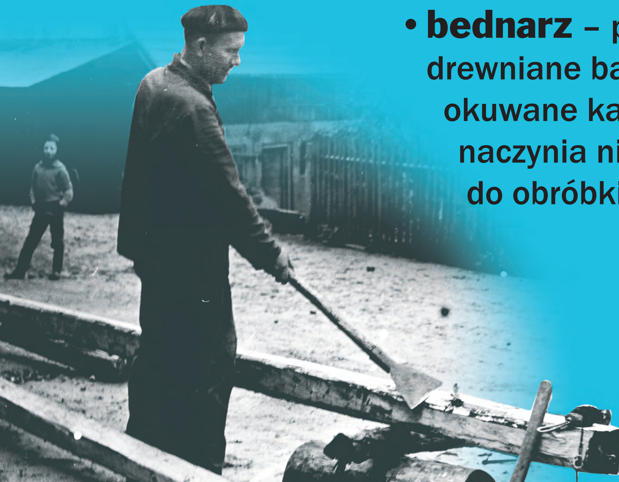
Cieśla przy pracy
